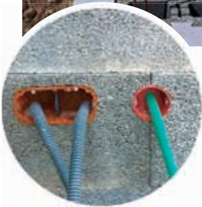
Vissage des boîtes électriques dans le bloc bois-ciment.
