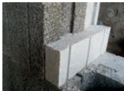
Clavetage des blocs tableaux évite le risque de décalage des 1/2 blocs tableaux lors du coulage du béton.
