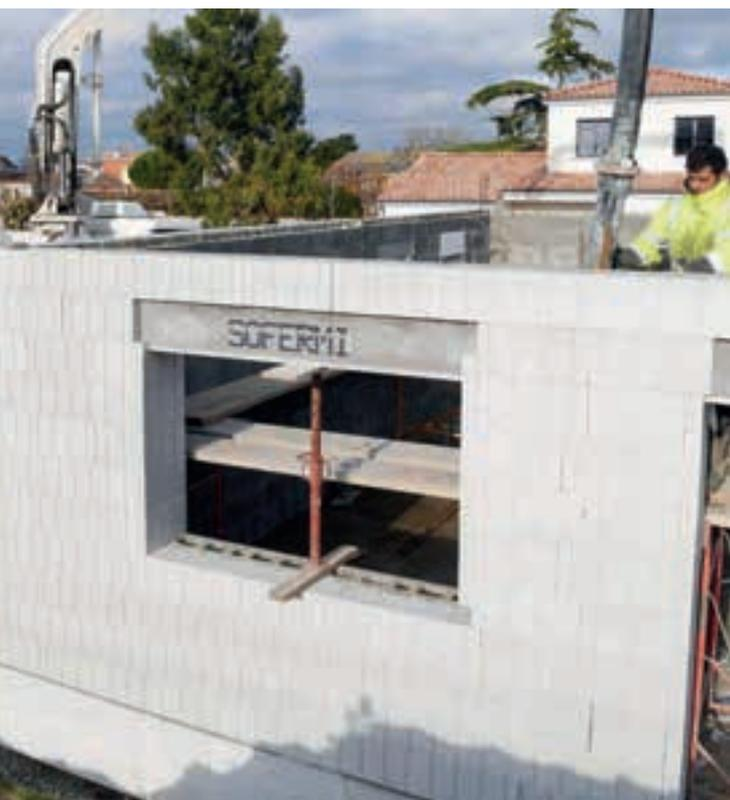
Lors de la fourniture du béton, demandez un «S» en bout de tuyau pour une meilleure maîtrise de remplissage des blocs.
