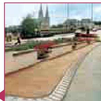
Le moulage des bordures et caniveaux préfabriqués en béton permet d'obtenir des surfaces podotactiles comportant les profils et reliefs garantissant la sécurité des personnes handicapées.
